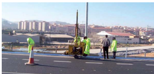
Taladro para el hincado del soporte de la bionda.
