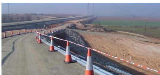
Instalación de bionda en carretera de baja intensidad circulatoria.
